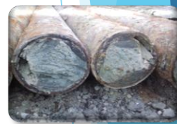
充填状況(施工実証)
